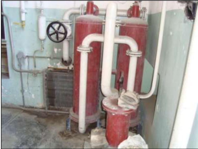
Slika 14: Vodeni osigurač i glavni ventil
